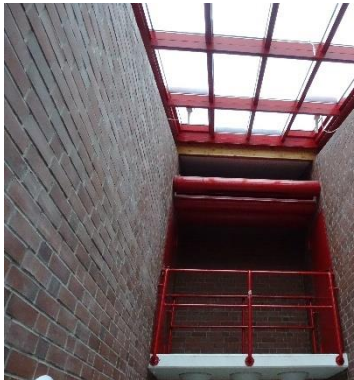
Eingangsbereich mit Dachfenster
