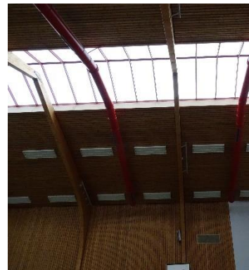
Dachfenster in der Turnhalle
