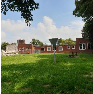
Abbildung 7 Blickrichtung Nord- osten, nördlicher und zentraler Klassen- trakt und Verbindungsbauteil. Die an der nördlichen Gebäu- deseite angebaute Wohnung war im Abbruch.
