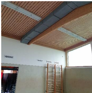
Abbildung 10 Turnhalle von Innen mit RLT Leitungen
