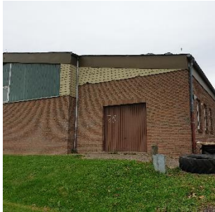
Abbildung 7 Blickrichtung Norden, Turnhalle
