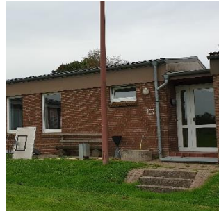
Abbildung 8 Blickrichtung Norden, Eingang
