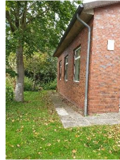
Abbildung 9 Blickrichtung Süden, Tor zur Fahrzeughalle
