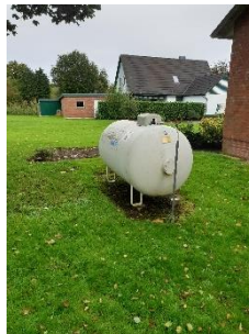
Abbildung 14 Flüssiggastank
