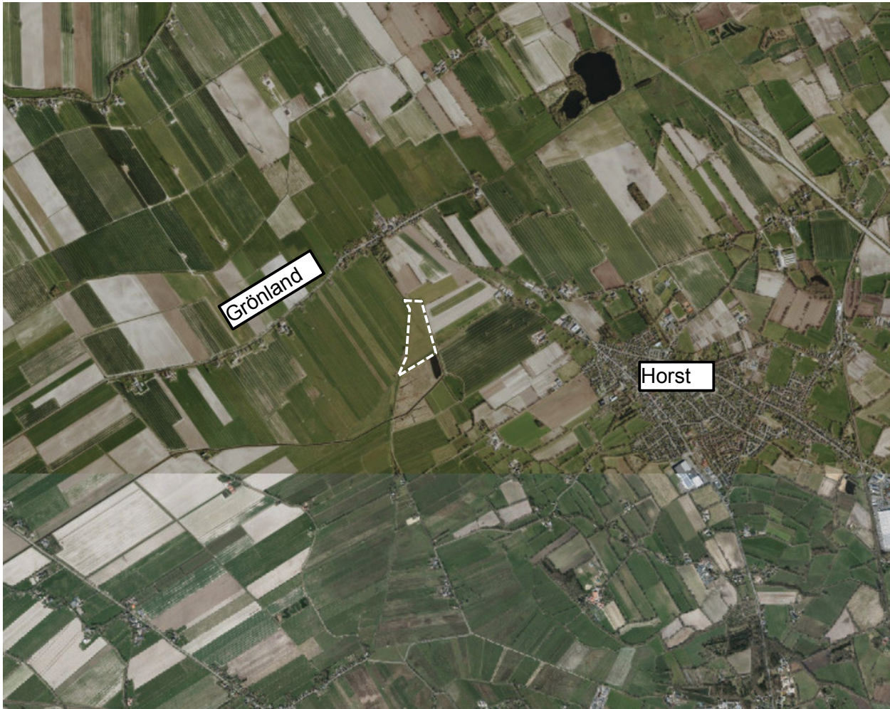
Abb. 1: Räumlicher Geltungsbereich der 31. F-Planänderung und des vorhabenbezogenen B-Plans Nr. PV 2 in der Gemeinde Horst
