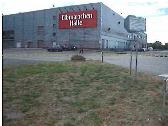
Abb. 9: Gebäudeteil, der umgenutzt werden soll
